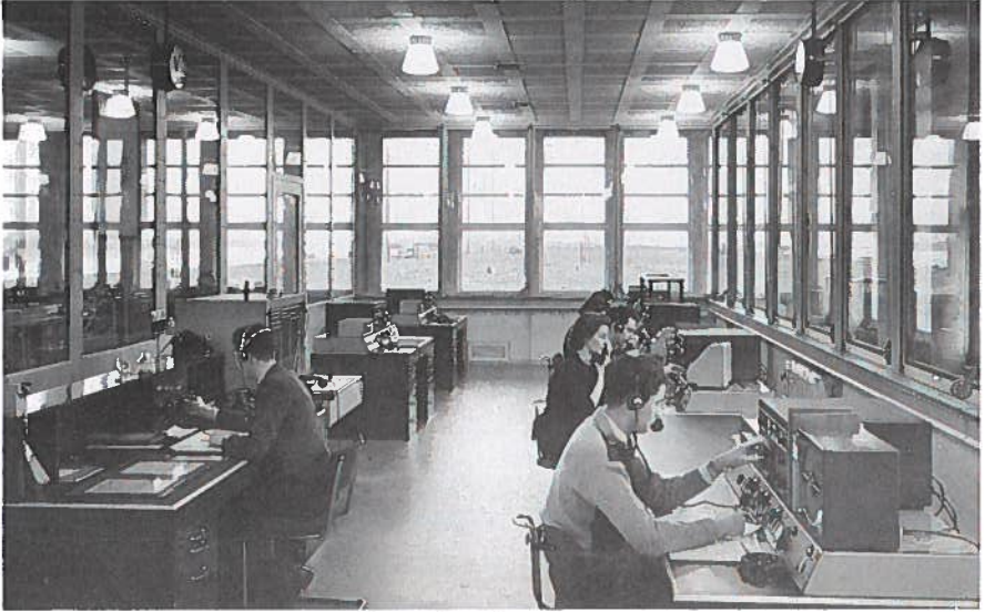
afb. 3. Interieur Telefoniezaal Tweede Sluiseiland
